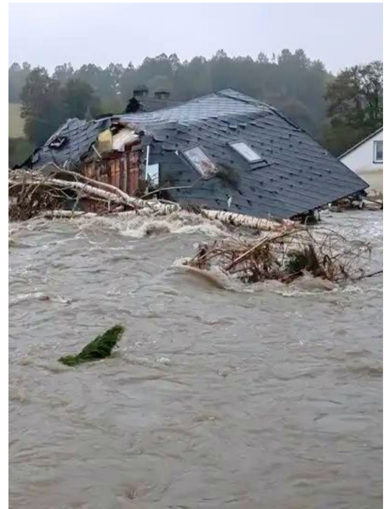
Crecida. Seguirá incrementando el nivel de los ríos
